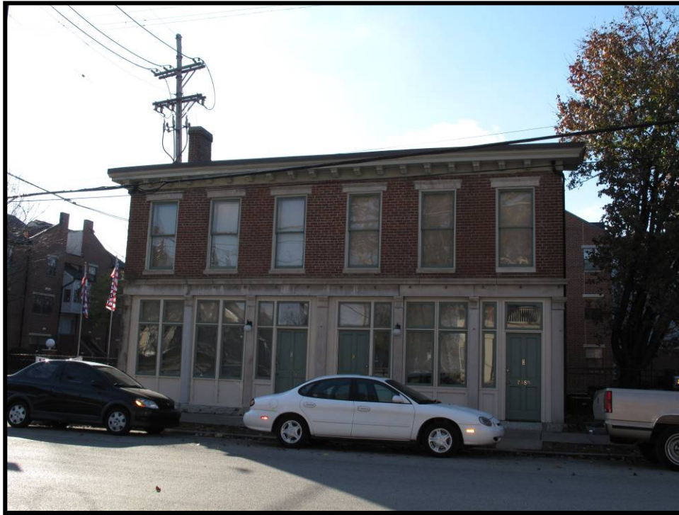
Figure 4. 65 Façade of 738-740 Muhammad Ali Boulevard (JFCH-442).
